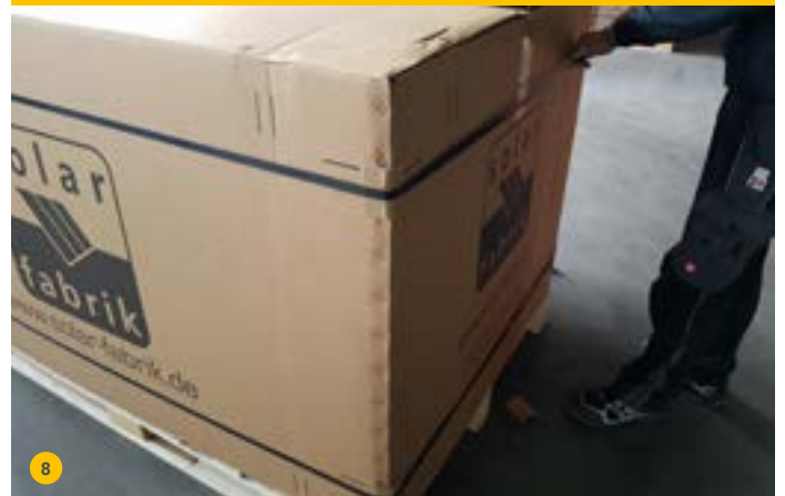
Allentare il fissaggio orizzontale
